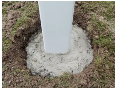
Schritt 2: Beton in Erdreich
